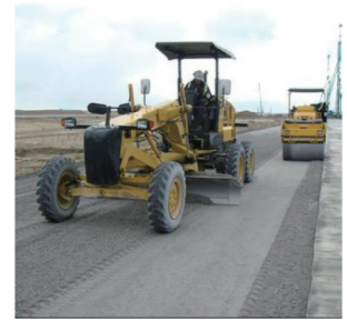
写真 2 鉄鋼スラグ路盤材と道路施工状況
