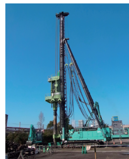
写真6 サンドコンパクションパイプ施工状況
