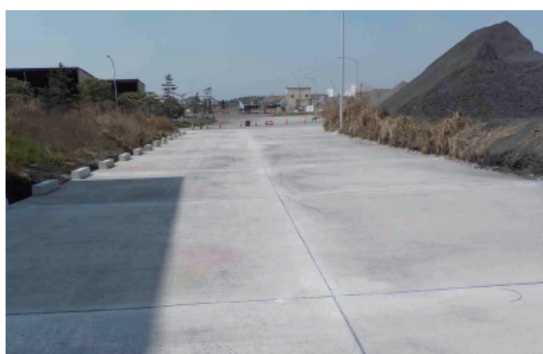
写真11 海水練りフェロフォーム®舗装 Photo 11 Ferroform™ pavement by sea water
