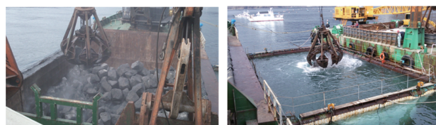
写真12 大船渡港湾口防波堤工事での施工状況 Photo 12 Construction of breakwater at Oofunato harbor entrance
