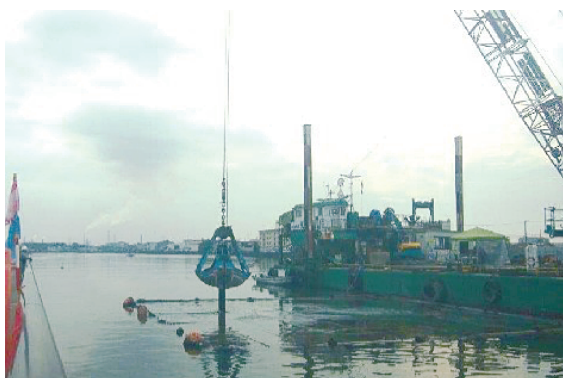
写真10 福山内港へのマリンストーン®施工状況 Photo 10 Construction of Marine stone™ in Fukuyama inner harbor
