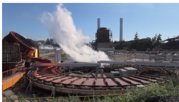
写真13 高炉スラグ連続凝固プロセス PACSS® Photo 13 Continuous solidification process for blast furnace slag PACSS™
